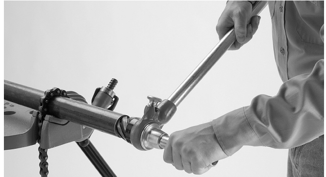
Figure 4 – Escariado del extremo del tubo
