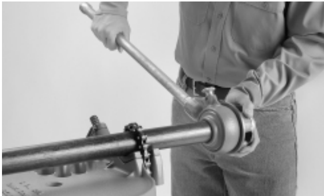
Figura 3 – Montaje de la Roscadora en el tubo
