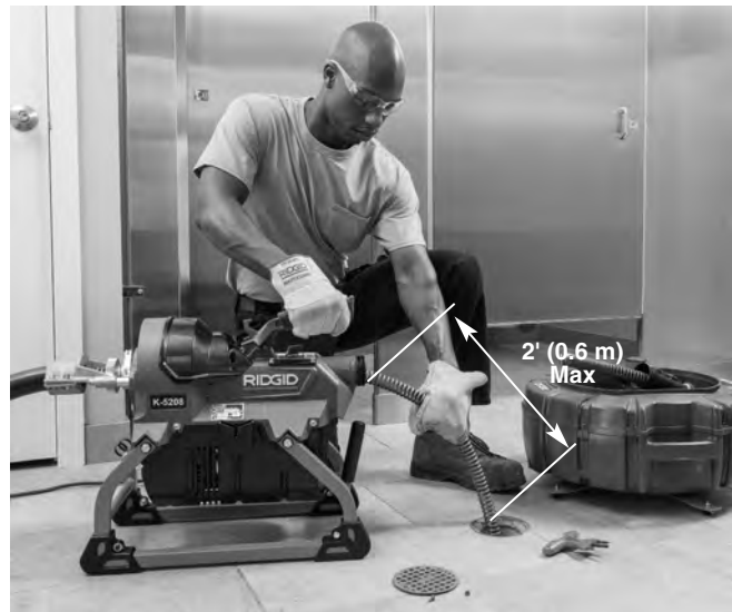
Figura 9 – El operario en posición de trabajo
