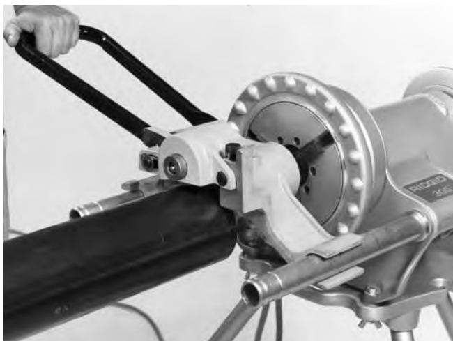
Figure 12 – Exécution du rainurage
