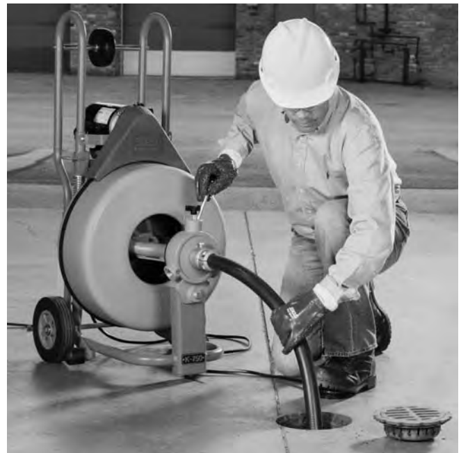
Figura 15 – Empleo de una limpiadora con manguera-guía delantera
